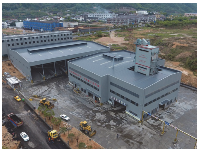
Рис. 3. Асфальтобетонный завод закрытого типа в Китае
